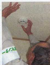
火災警報器取付け
