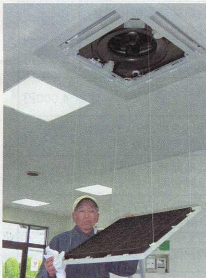
地域貢献班 空調機清掃
