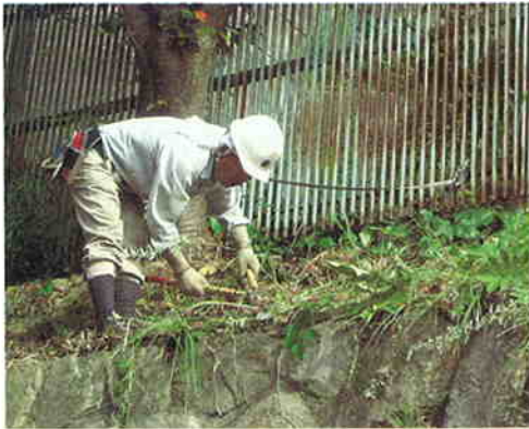
斜面、高所の作業では、転落事故を防止するために、安全帯（命綱）をつけて作業します
