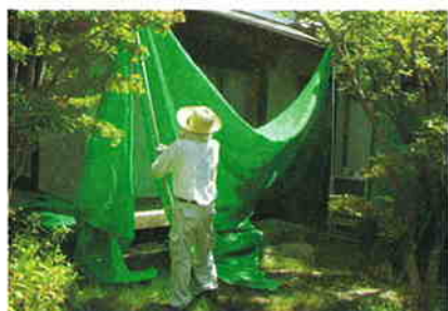
建物の損傷を防ぐために保護シートをかけます
