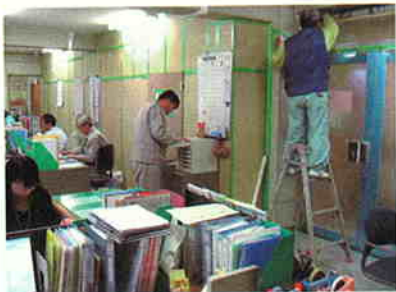
工事中の事務所
