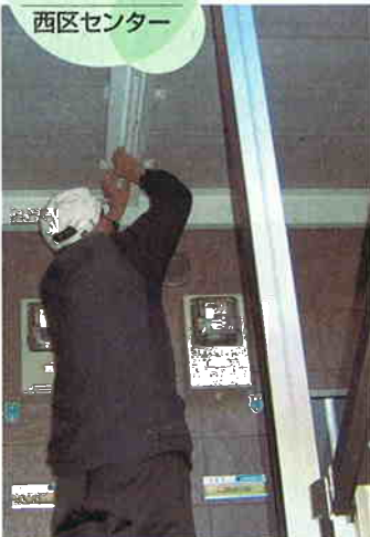
蛍光灯の取替え作業
